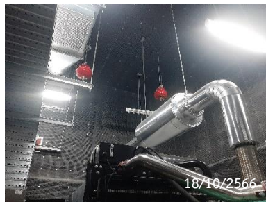
ท่อระบายไอเสียจากห้อง Generator
